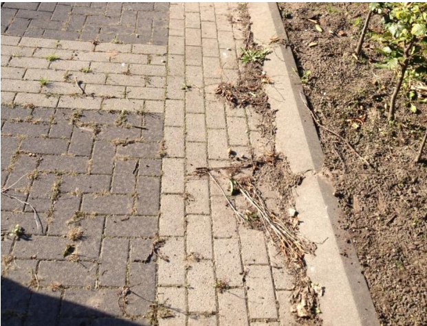
Figuur 6: Vervuiling van de verharding door groenstroken
