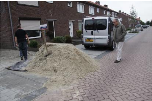
Figuur 7: Vervuiling van de verharding door het storten van zand
