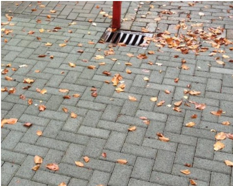
Figuur 23: Noodkolk op het laagste punt
